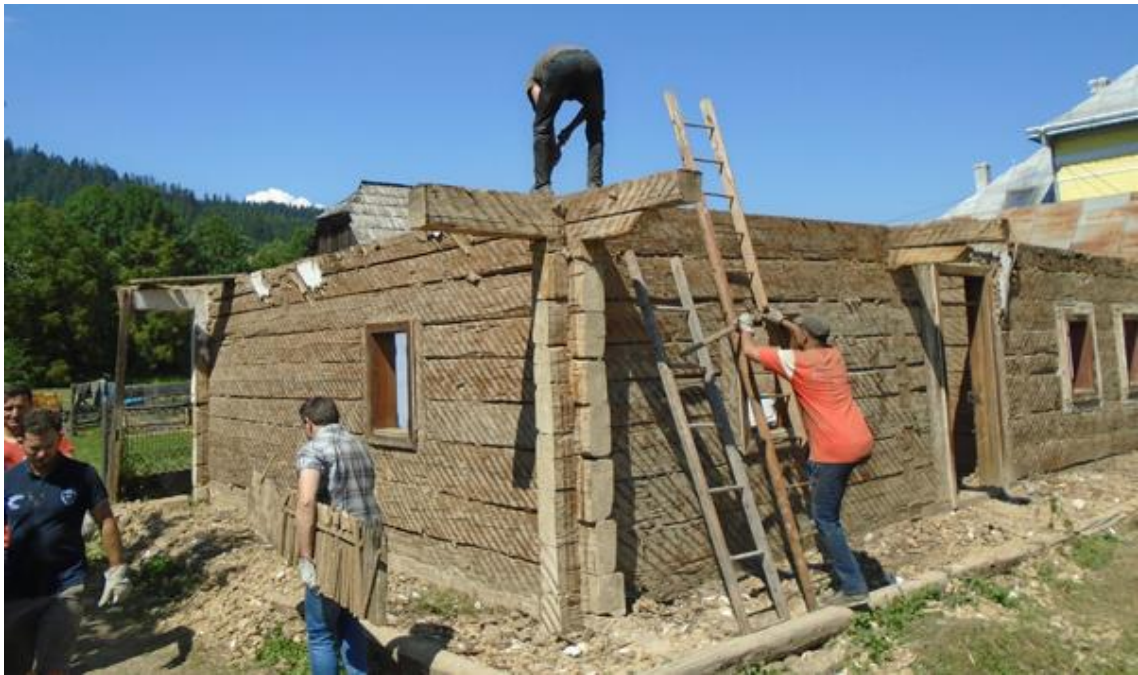
Figura 20. Relocarea Casei Aionițoaie din Putna. Sursa: Pascal Garnier.
